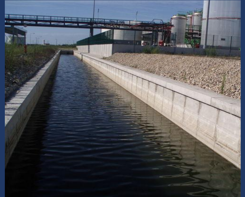
Wybetonowane kanały z wodą
