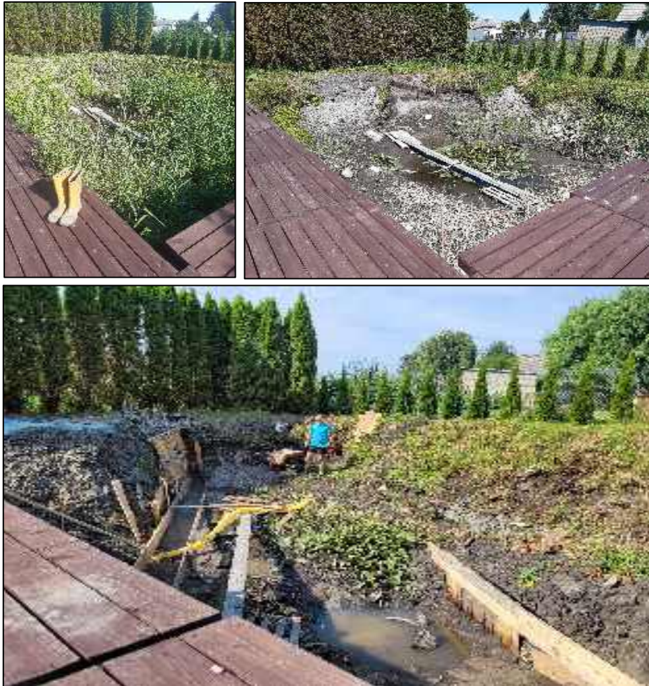
Rys. 25. Przebudowywany obiekt w czasie wstępnych robót hydrotechnicznych (fot. W. Walczak)
