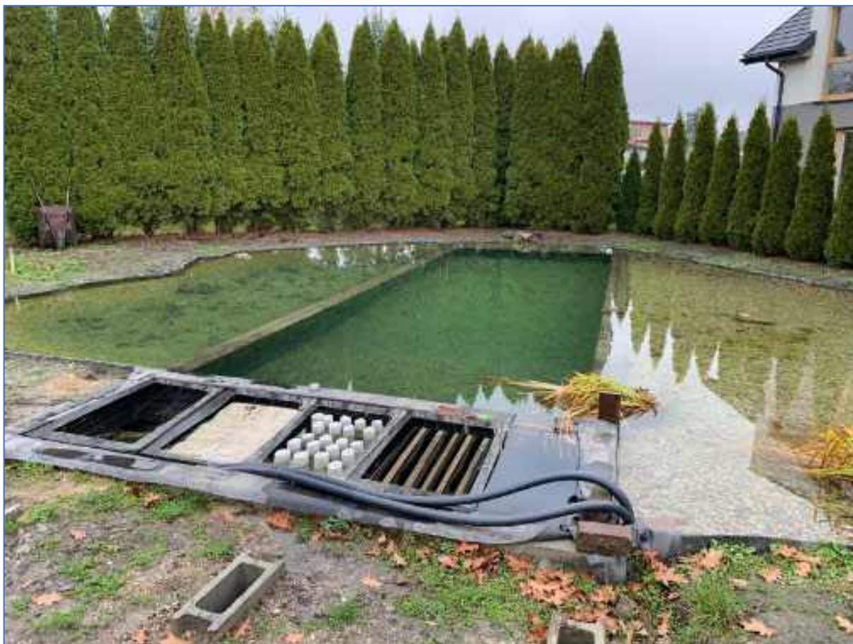
Rys. 28. Widok na nowo powstały ekobasen z wdrożeniem modułowego system filtracji wody (fot. W. Walczak)
