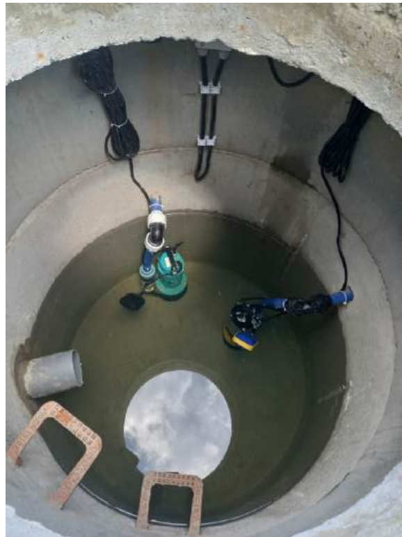
Fotografia 3. Złoża gruntowo-roślinne i przepompownia ścieków oczyszczonych w trakcie budowy i po wykonaniu. Złoża - dolna fotografia z lewej strony; przepompownia - dolna fotografia z prawej strony.
