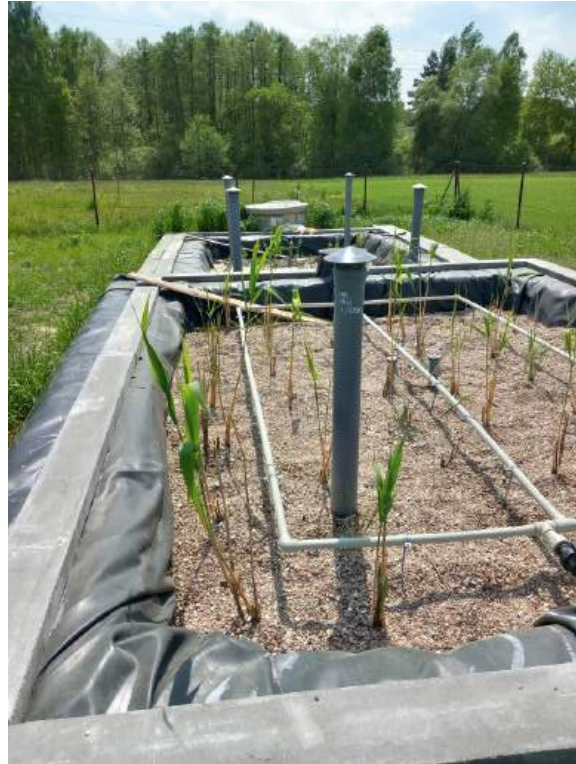
Fotografia 4. Sadzenie roślin na złożach gruntowo-roślinnych (fotografia z lewej strony). Złoże I typu VF z pionowym przepływem ścieków obsadzone trzcina pospolitą, Złoże II typu HF z poziomym przepływem ścieków obsadzone wierzbą wiciową (fotografia z prawej strony).
