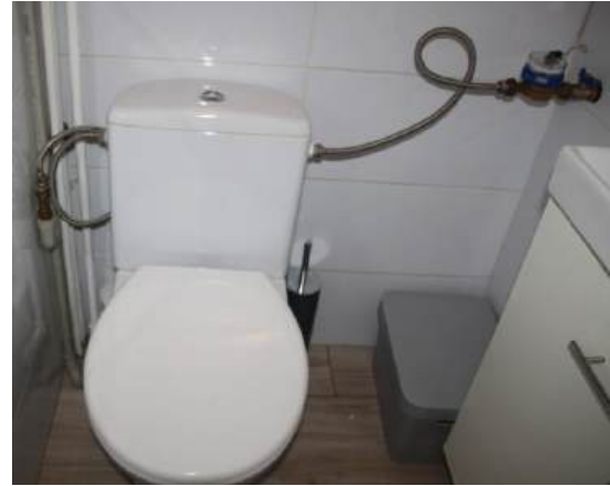
Fotografia 6. Instalacja do doczyszczania ścieków oczyszczonych ulokowana w piwnicy budynku mieszkalnego (fotografia po lewej stronie) i toaleta z przyłączem ścieków oczyszczonych (fotografia po prawej stronie).
