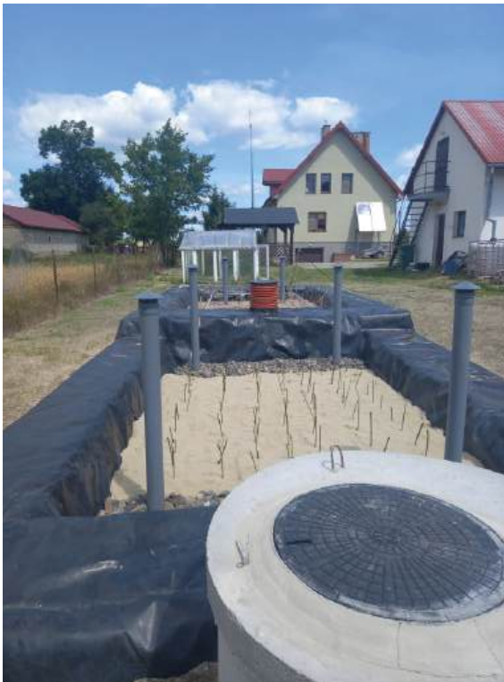
Fotografia 7. Wdrożona hybrydowa hydrofitowa oczyszczalnia ścieków z zamkniętym obiegiem wody: złoża zaraz po oddaniu do użytku (fotografia z lewej strony); osadnik wstępny (fotografia z prawej strony).
