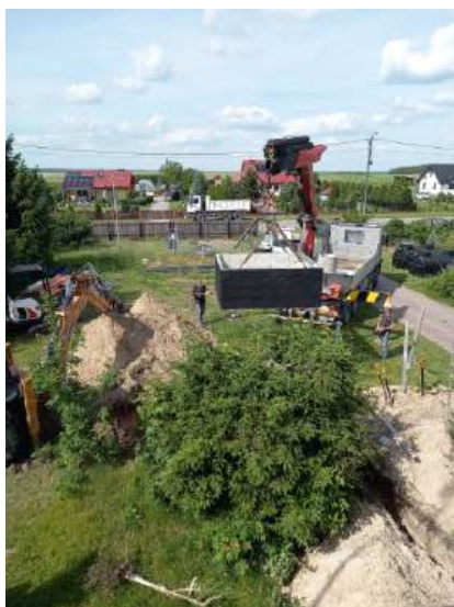
Fotografia 2. Instalacja osadnika wstępnego i przepompowni ścieków surowych.
