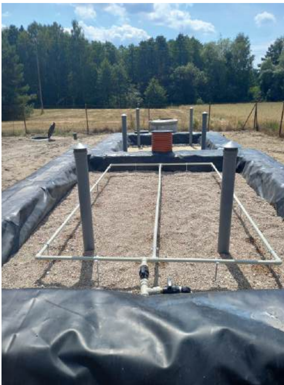
Fotografia 3. Złoża gruntowo-roślinne i przepompownia ścieków oczyszczonych w trakcie budowy i po wykonaniu. Złoża - dolna fotografia z lewej strony; przepompownia - dolna fotografia z prawej strony.
