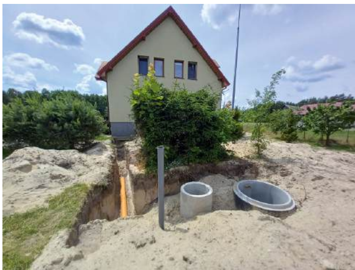
Fotografia 2. Instalacja osadnika wstępnego i przepompowni ścieków surowych.
