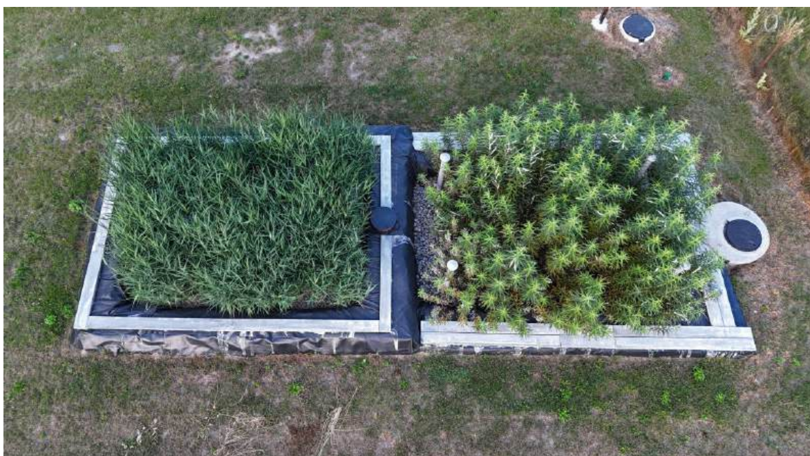
Fotografia 8. Wdrożona hybrydowa hydrofitowa oczyszczalnia ścieków z zamkniętym obiegiem wody w trzecim roku użytkowania (2024 rok).
