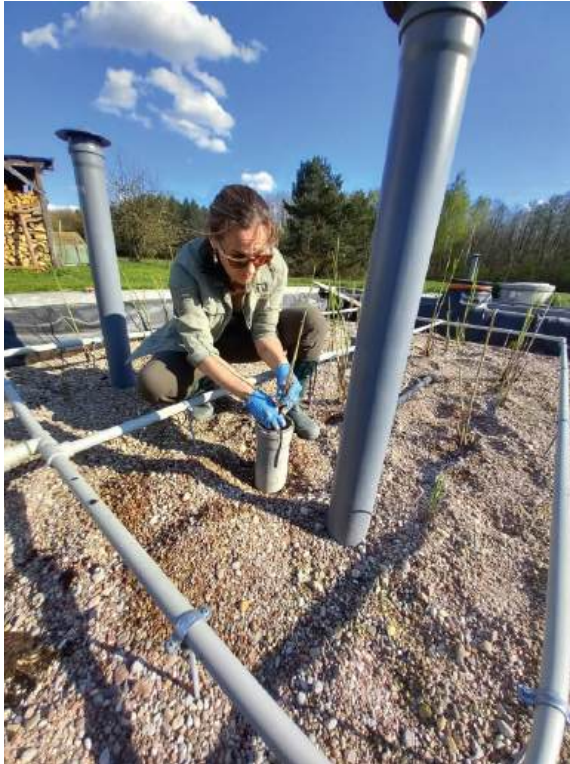
Fotografia 4. Sadzenie roślin na złożach gruntowo-roślinnych (fotografia z lewej strony). Złoże I typu VF z pionowym przepływem ścieków obsadzone trzcina pospolitą, Złoże II typu HF z poziomym przepływem ścieków obsadzone wierzbą wiciową (fotografia z prawej strony).
