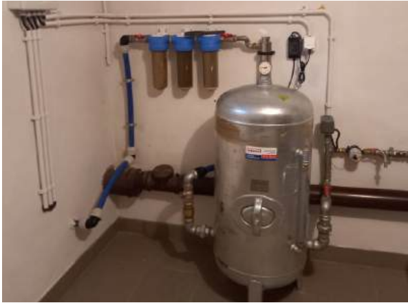
Fotografia 6. Instalacja do doczyszczania ścieków oczyszczonych ulokowana w piwnicy budynku mieszkalnego (fotografia po lewej stronie) i toaleta z przyłączem ścieków oczyszczonych (fotografia po prawej stronie).
