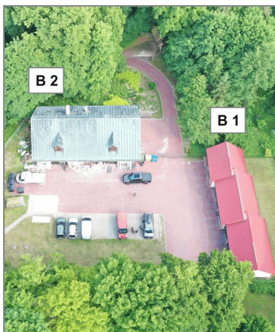
Ryc. 5. Widok budynku garażowego (B1) i warsztatowego (B2) przy dyrekcji Roztoczańskiego Parku Narodowego (Fot. Kaproń B.)
