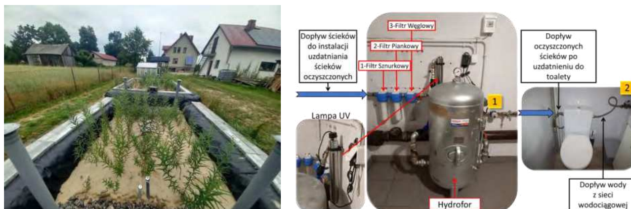
Ryc. 1. Hybrydowa hydrofitowa oczyszczalnia ścieków z zamkniętym obiegiem wody w miejscowości Kulczyn, w Poleskim Parku Narodowym, wraz z rysunkiem instalacji do uzdatniania, magazynowania i dostarczania uzdatnionych ścieków, zainstalowanej w piwnicy budynku
