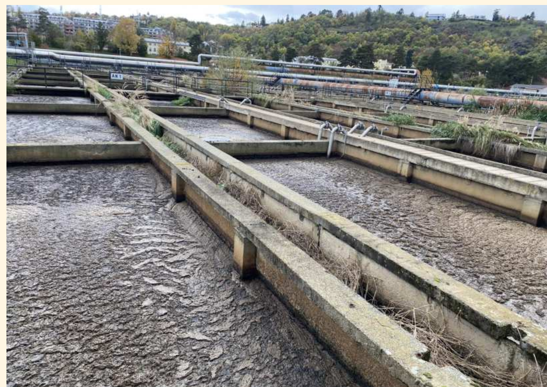
Centralna Oczyszczalnia Ścieków w Pradze
