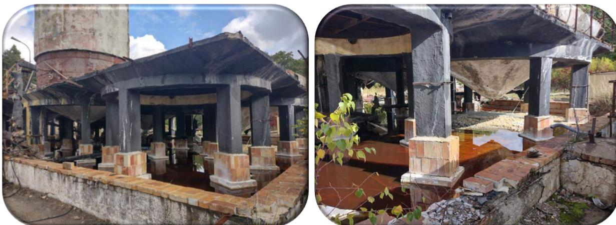
**Fotografia 2.** Cysterny z płynnym odpadem, umieszczone nad betonowym zbiornikiem.
