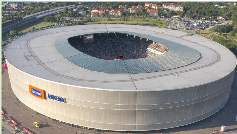
Tarczyński Arena Wrocław – 37 000 m 2 dachu, rocznie około 10 000m 3 wody opadowej, zasilanie około 1200 toalet + nawadnianie murawy
