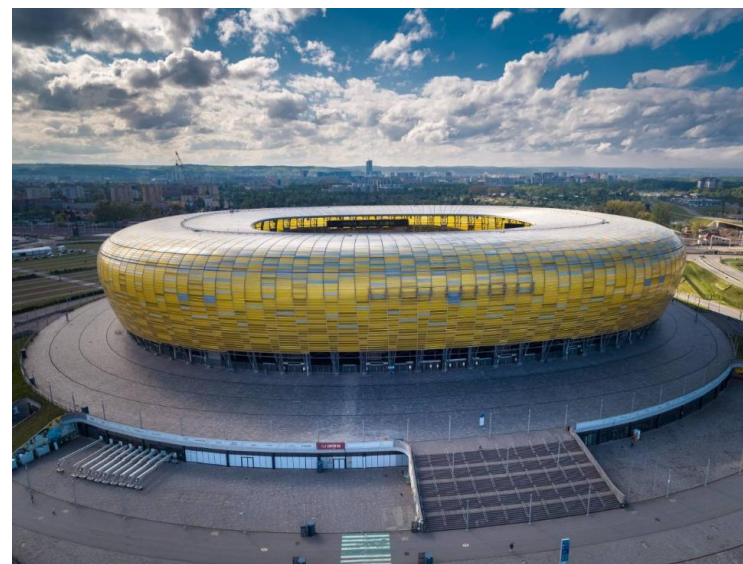
Energa Gdańsk zasilanie toalet + nawadnianie murawy
