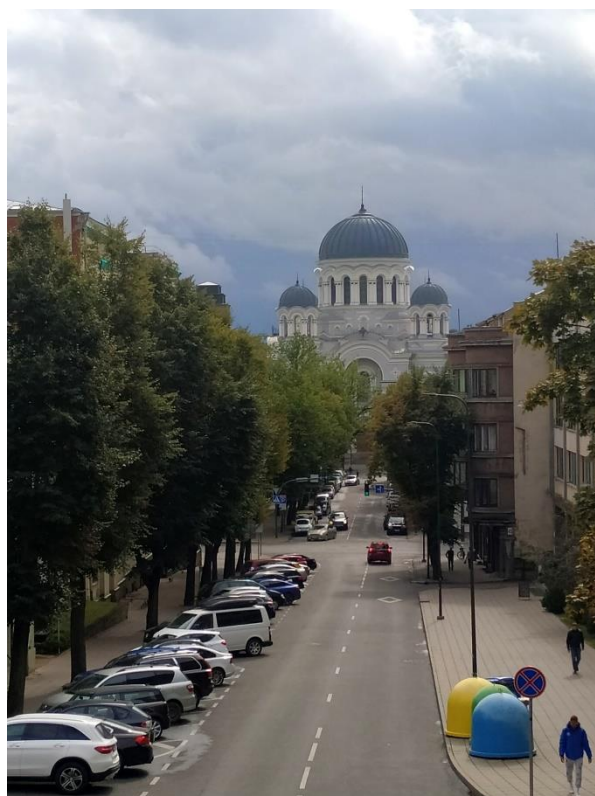
Fot. 10. Kościół św. Michała Archanioła.
