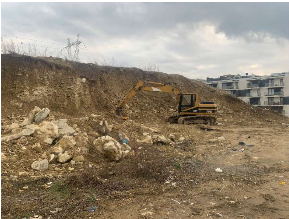
Ryc. 3. Aggerosole powstają przez nasypianie dużej ilości materiału ziemistego, np. przy robotach budowlanych. Osiedle Słoneczna Dąbrowa w Lublinie
