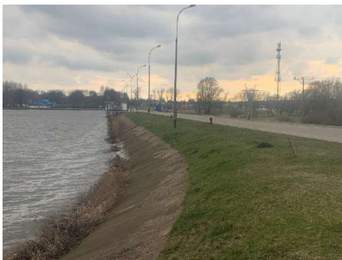
Ryc. 8. Wykorzystanie gleby technogenicznej do budowy grobli nad Zalewem Zemborzyckim
