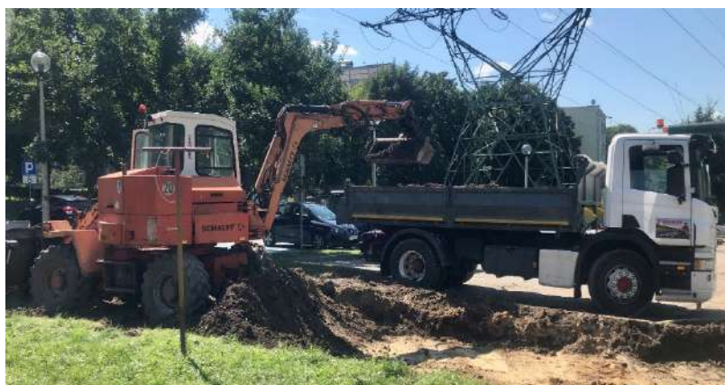
Ryc. 2. Załadunek ziemi na wywrotkę
