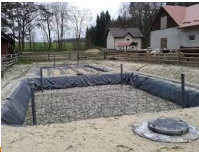
Oczyszczalnia hydrofitowa przy leśniczówce RPN, ul. Biłgorajskiej w Zwierzyńcu
