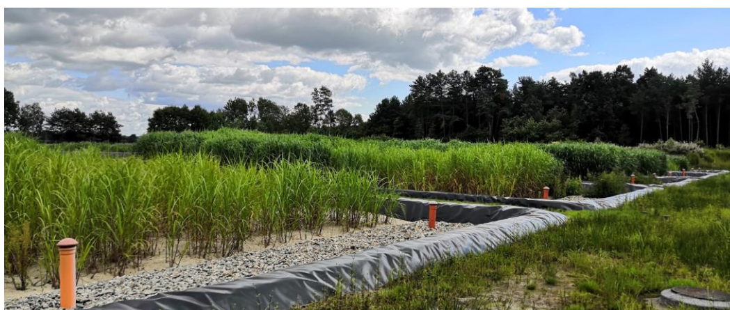
Największa w Polsce hybrydowa hydrofitowa oczyszczalnia ścieków w Białce nad jez. Białskim (gmina Dębowa Kłoda) o przepustowości 180 m 3 /d
