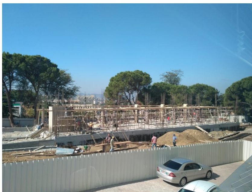
Fot.2. Odbudowa budynku wydziału po trzęsieniu ziemi w 2019 roku
