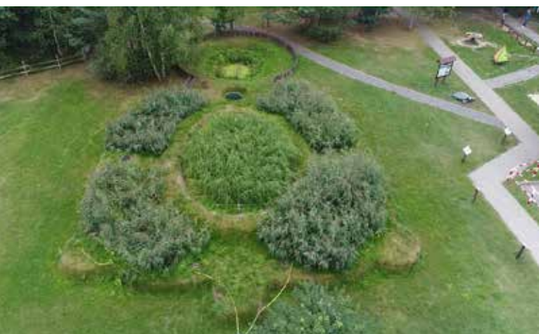
Hybrydowa hydrofitowa oczyszczalnia ścieków w kształcie żółwia w Starym Zątczu, przy Ośrodku Dydaktyczno-Muzealnym PPN. Fot. Radomir Obroślak
