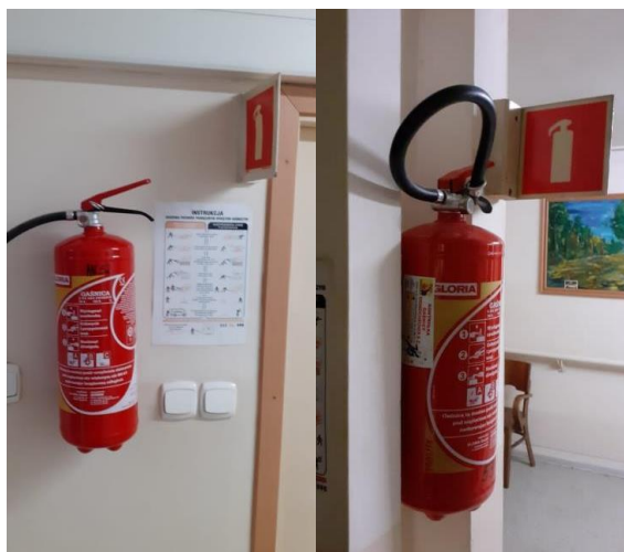
Fot. 2. Gaśnice w kontrolowanym obiekcie (fot. własna)
