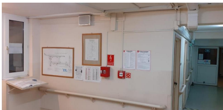
Fot. 1. Przeciwpożarowy wyłącznik prądu (fot. własna)
