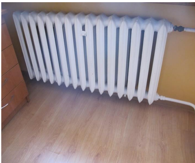
Fotografia nr 7. Grzejnik w korytarzu
