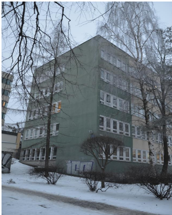
Fotografia nr 5. Elewacja budynku
