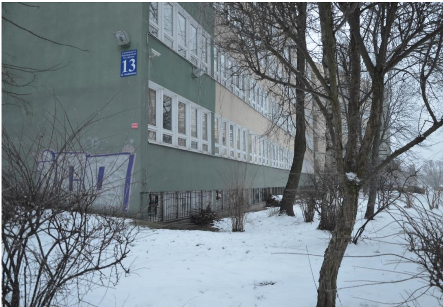
Fotografia nr 4. Elewacja budynku.
