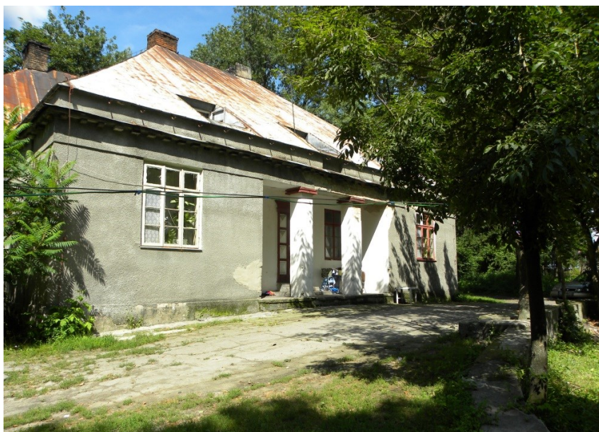
Fot. 6. Dwór w Ciechankach, elewacja wschodnia (fot. M. Dudkiewicz, 2009)
