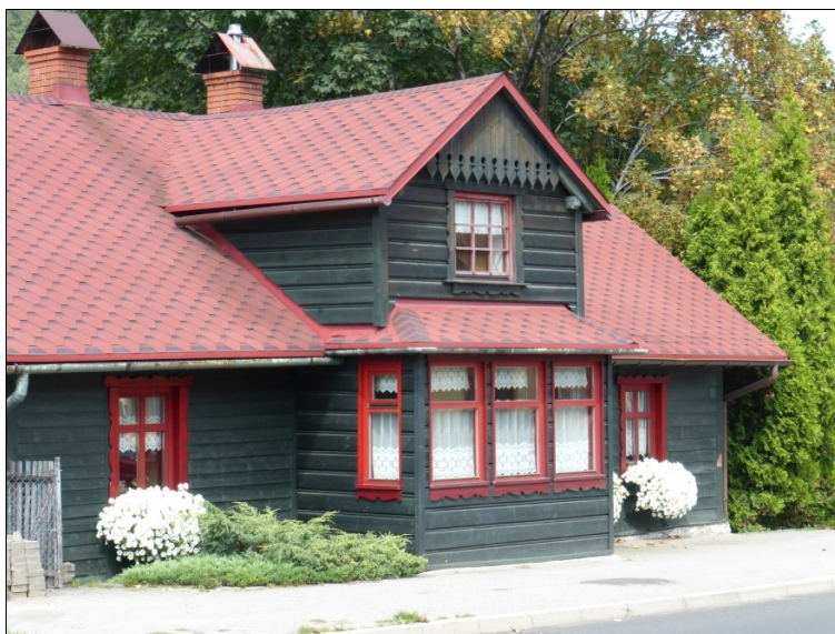
Ryc. 1. Drewniany budynek w Szczyrku, reprezentujący styl regionalny. Uwagę zwraca frontowa, dwukondygnacyjna przybudówka oraz bogaty detal architektoniczny (fot. T. Malec)
