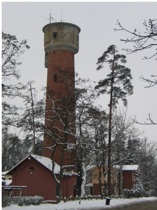
Ryc. 3. Sosny były zawsze ważnym elementem krajobrazu Spaly, sięgając najwyższego obiektu, jakim jest wieża ciśnień, pochodząca jeszcze z carskich czasów (fot. M. Milecka, 2007)
