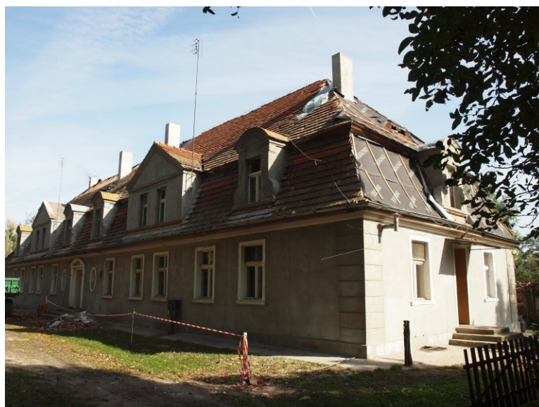
Ryc. 4. Dawna oficyna w trakcie prac remontowych (fot. R. Gubańska, 2012)
