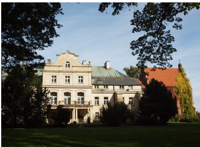
Ryc. 2. Widok na pałac z dobudowaną kaplicą od strony parku (fot. R. Gubańska, 2012)
