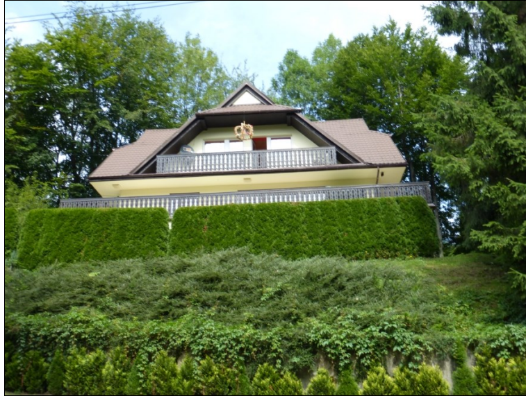
Ryc. 4. Murowany, ciężki dom letniskowy, posadowiony na stromym zboczu góry w Brennej. U dołu fotografii, porośnięte roślinnością, znajdują się mury oporowe znacznych rozmiarów (fot. T. Malec)
