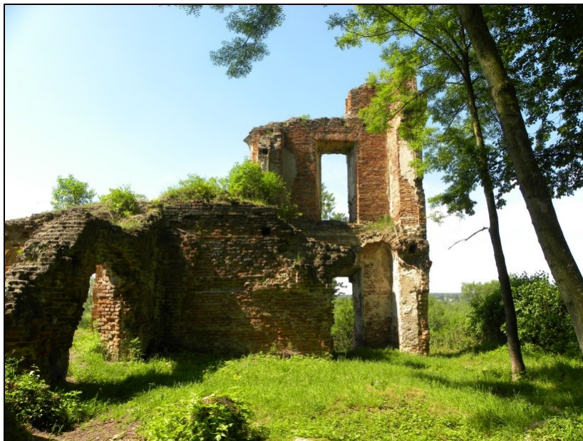
Fot. 1. Ruiny zamku w Zawieprzycach (fot. M. Dudkiewicz, 2012)
