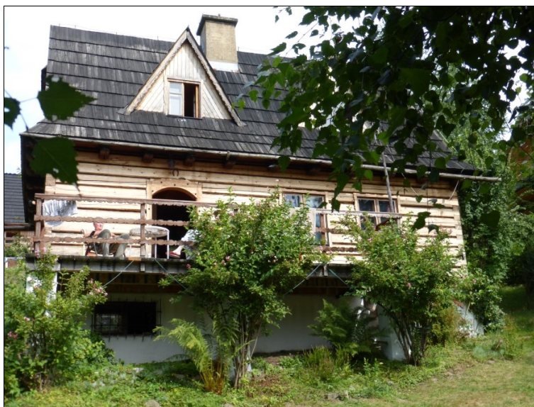
Ryc. 3. Drewniany, posadowiony na murowanej podmurówce średnich rozmiarów dom letniskowy w Brennej. Widoczny stosunkowo skromny detal architektoniczny (fot. T. Malec)
