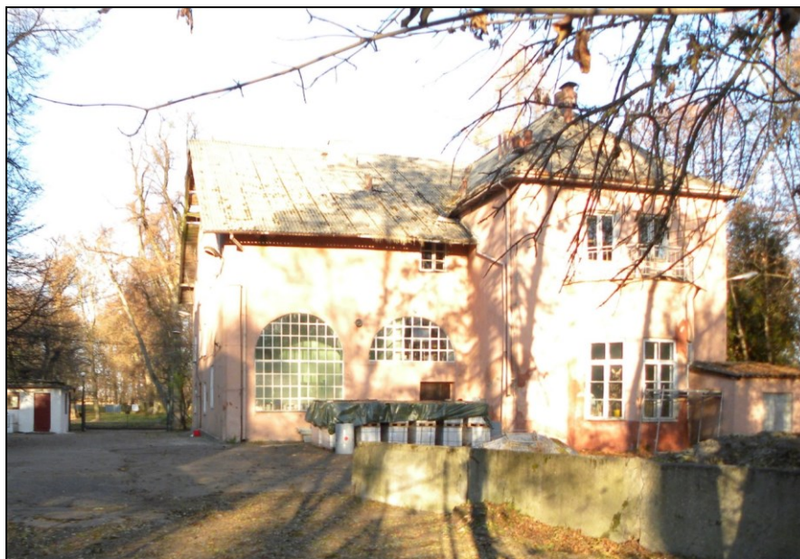
Fot. 3. Pałac w Łęcznej (fot. M. Dudkiewicz, 2012)
