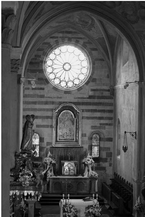
Opisana, odsłonięta ściana prezbiterium wąchockiego kościoła ze skutą polichromią
