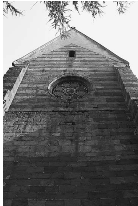
Zewnętrzna elewacja z widocznym wątkiem
