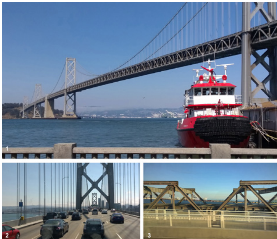
Il. 8. Most San Francisco-Oakland Bay, odcinek zachodni. 1 – widok ogólny, 2 – pokład górny, 3 – demontaż kratownic mostu Modrzejewskiego
