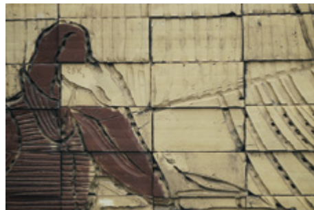
Il. 10. Ceramiczne kafle mozaiki z widoczną numeracją, pomocną w ułożeniu motywu Fot. R. Józwik, 2016
