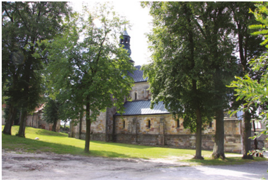
Il. 16. Relikt cmentarza klasztorowego możemy odnaleźć w symbolicznym miejscu przy północnej ścianie kościoła w Sulejowie – dawniej opactwa cysterskiego
