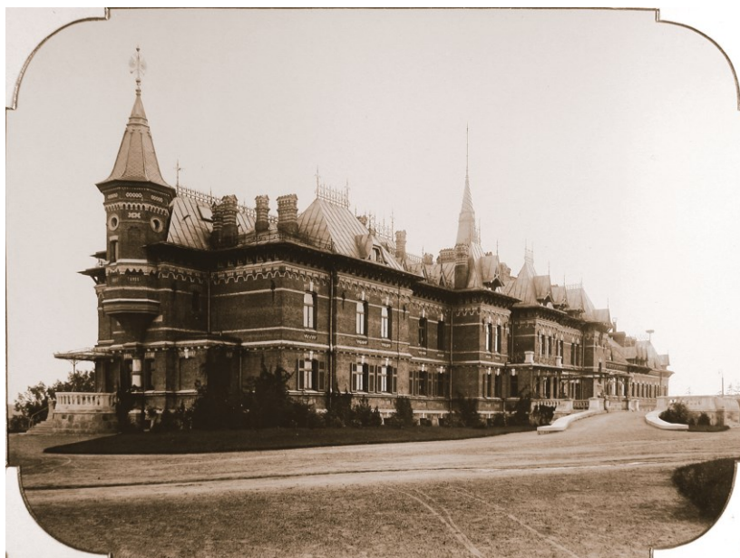
Ryc. 5. Pałac carski w Białowieży, lata 90. XIX w. [źródło: S. Czestnych, K. Kettering, Białowieża – carska rezydencja , Warszawa 2010]
