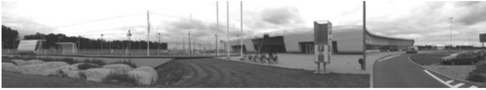
Il. 2. Airport Lublin w Świdniku ze stacją nowej zelektryfikowanej linii kolejowej łączącej terminal portu z Lublinem
