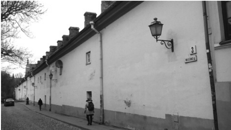
Il. 5. Klasztor bernardynek na Zarzeczcu – obecnie budynek mieszkalny
