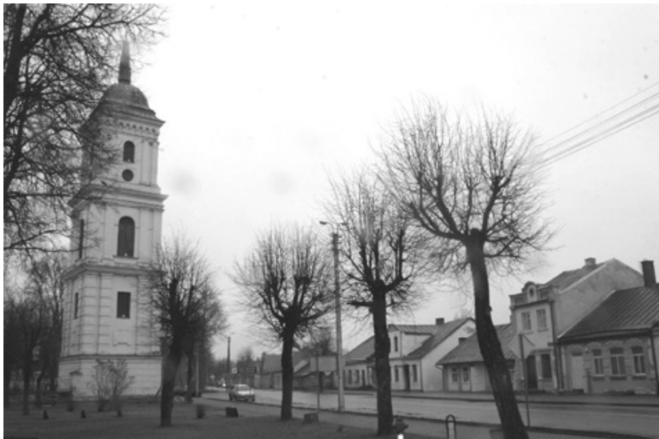
Il. 11. Kościół pw. św. Trójcy oraz klasztor bernardynów. Zauważalna jest duża różnica w skali pomiędzy dzwonnicy a budynkami mieszkalnymi.
