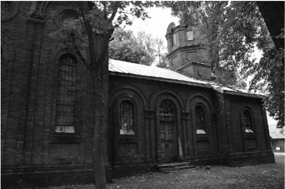
Ryc. 2. Elewacja wschodnia cerkwi w Dubience, stan wrzesień 2017 r.
