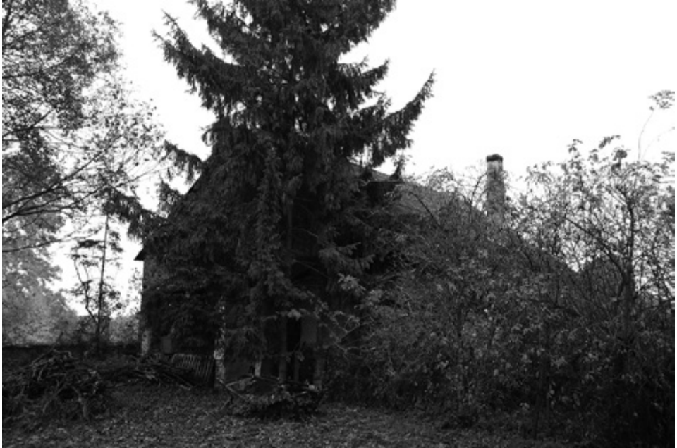
Il. 9. Budynek dawnego młyna w części dworskiej
