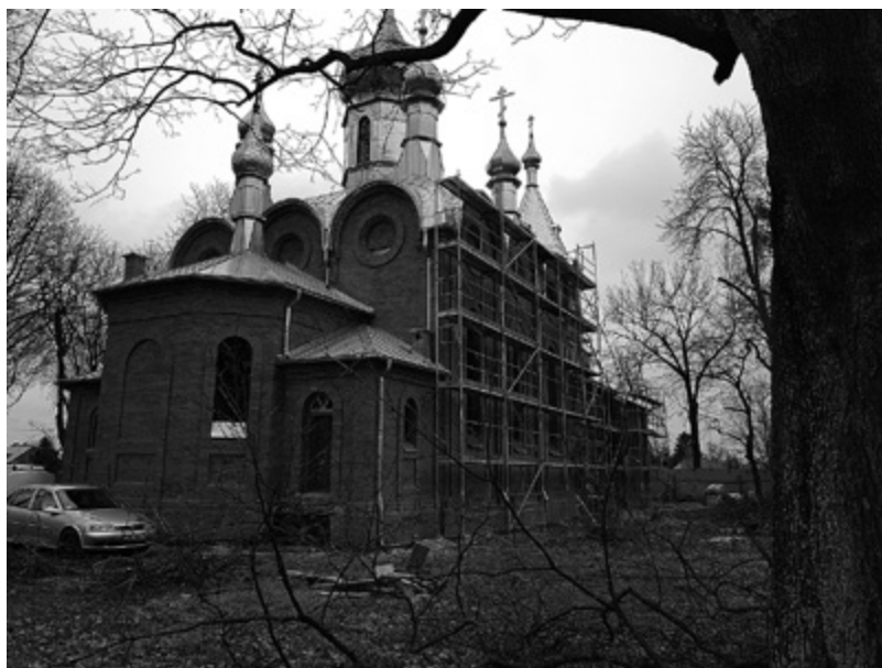
Il. 4. Prace remontowe. Elewacja zachodnia cerkwi w Dubience, stan marzec 2019 r.
