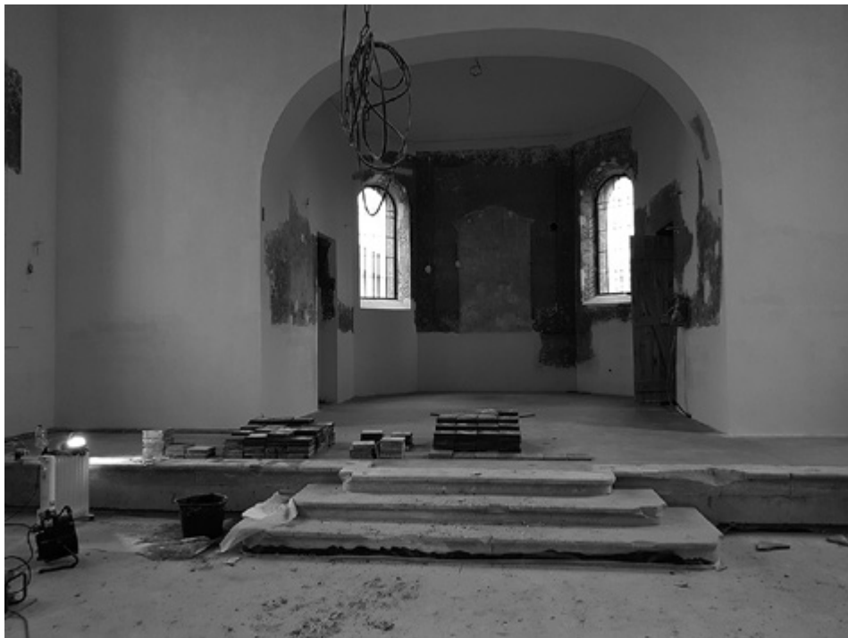
Il. 5. Prace remontowe. Wnętrze cerkwi, widok na ołtarz, stan marzec 2019 r.
