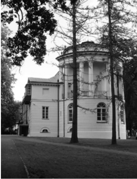
Il. 4. Elewacja wschodnia
