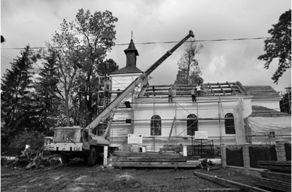
Il. 7. Prace remontowe. Elewacja południowa cerkwi w Uhrusku, stan wrzesień 2017 r. Fot. M. Dudkiewicz, 2017.
