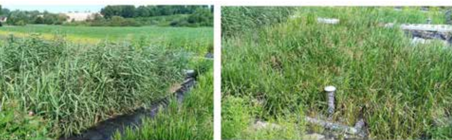
Hybrydowa hydrofitowa oczyszczalnia ścieków z miskantem olbrzymim i topinamburem w Skorczycach Fot. Krzysztof Józwiakowski
