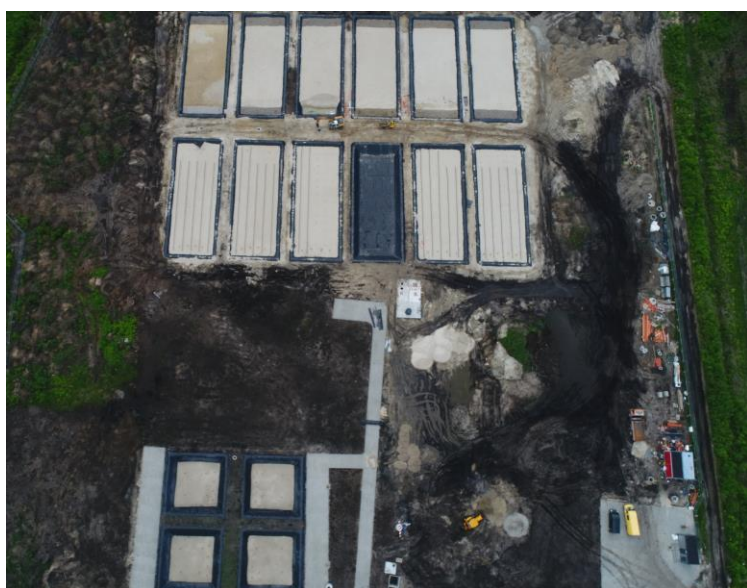
I sesja terenowa – Budowa hybrydowej hydrofitowej oczyszczalni ścieków nad jez. Bialskim (gmina Dębowa Kłoda) Fot. dr inż. Radomir Obroślak
