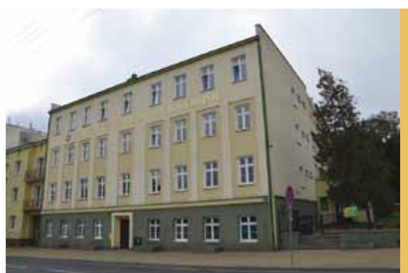
■ Wyremontowany budynek Wydziału Ogrodnictwa i Architektury Krajobrazu, 2015 r., fot. Biuro Promocji Uczelni
