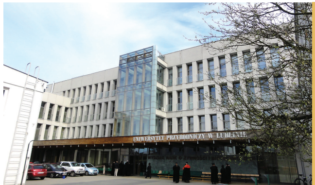
Obiekt Wydziału Nauk o Żywności i Biotechnologii przy ul. Skromnej oddano do użytku w 2005 r., stan z roku 2015, fot. Szwaigier
