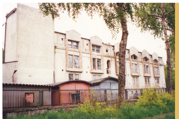
■ Budynek starej kottowni przebudowano na ośrodek sportu i siedzibę Pracowni Poligraficznej, widok od ul. Gtębokiej w czasie prowadzenia prac adaptacyjnych, 1994 r., fot. Archiwum WUP
