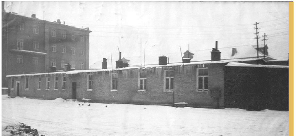
■ Pomieszczenia Zakładu Maszynoznawstwa Rolniczego przy ul. Lubartowskiej
