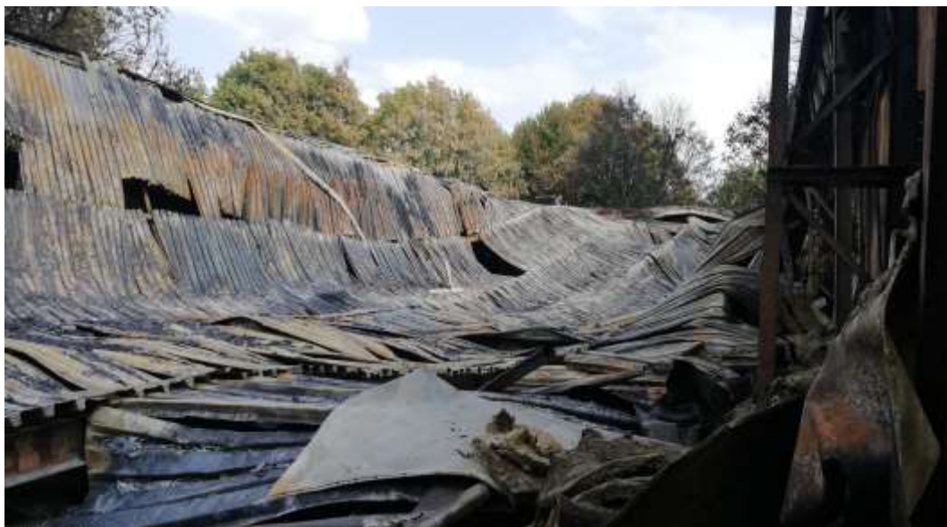
Fot. Nr 3,4 Widok dachu.
