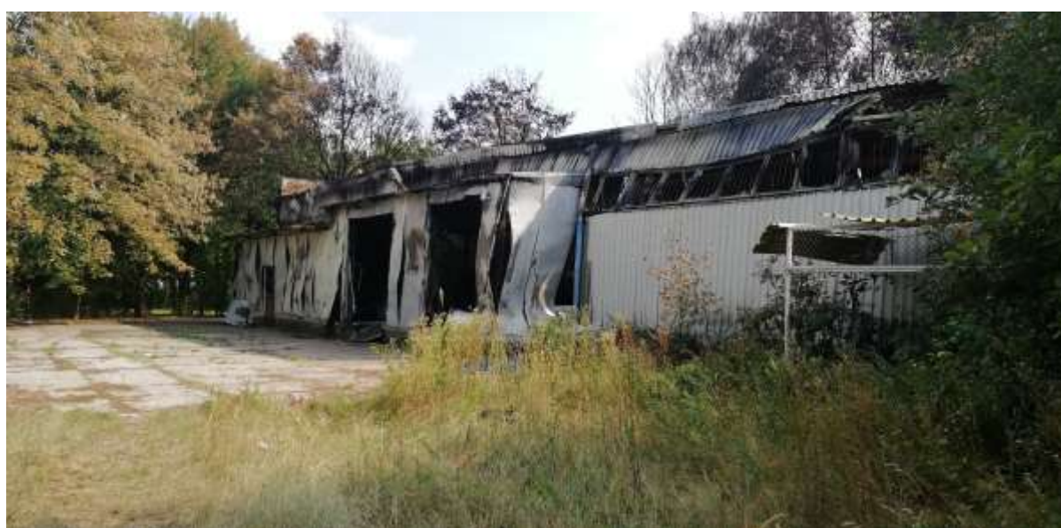
Fot. Nr 2. Elewacja od strony północnej.
